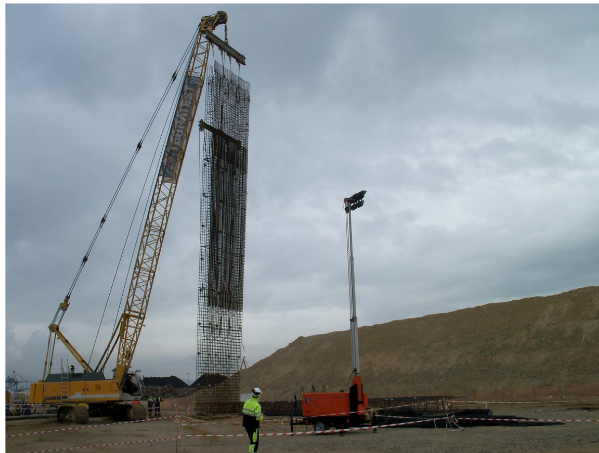
ILUSTRACIÓN 2 - INTRODUCCIÓN DE JAULA DE ARMADURA EN PANEL DE MURO PANTALLA
